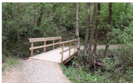
Slika 3: KT 10, MOSTIČEK NA POTI (geslo je pod zgornji robom ograje)
